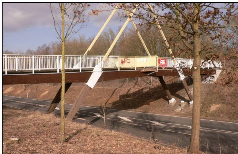
Fußwegüberführung als Stahl-/Holzkonstruktion über die Landesstraße 318 bei Diez
